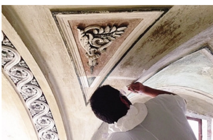
Una fase dei lavori nella chiesa del Carmine di Spirano
