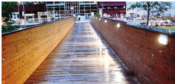
Il ponte ciclopedonale sul Brembo con i nuovi led FOTO ANDREATO
