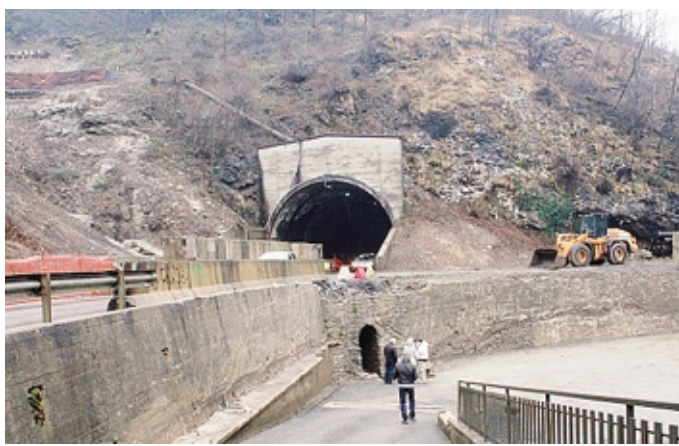
I lavori a gennaio 2015 sulla frana di Ponte Giurino di Berbenno
